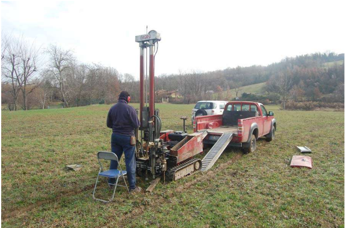
Fasi dell'esecuzione della prova penetrometrica CPT
