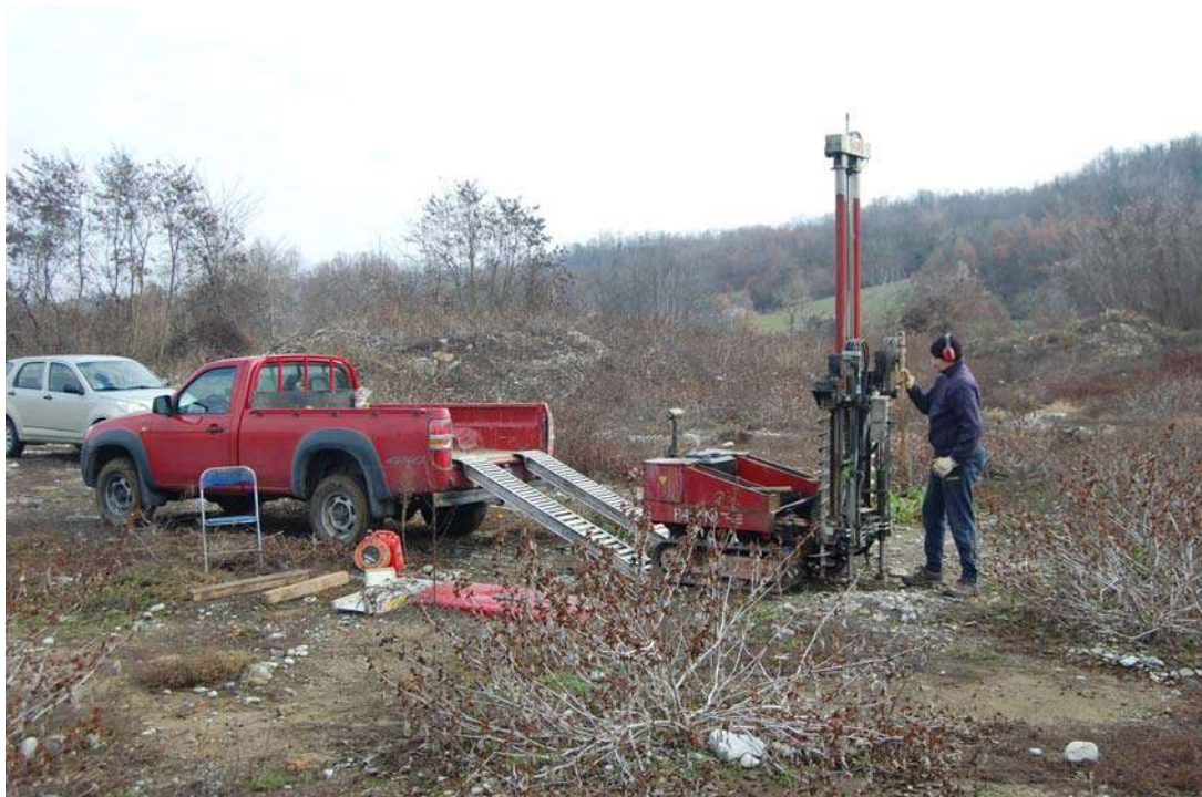
Fasi dell'esecuzione della prova penetrometrica SCPT
