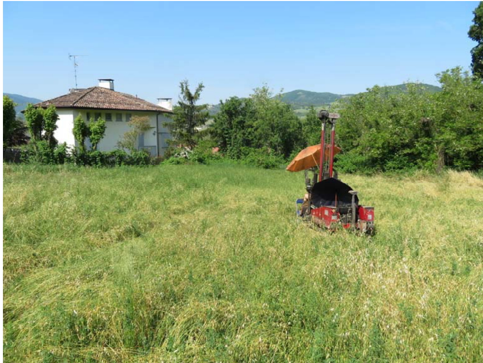
Fasi dell'esecuzione della prova penetrometrica CPT1
