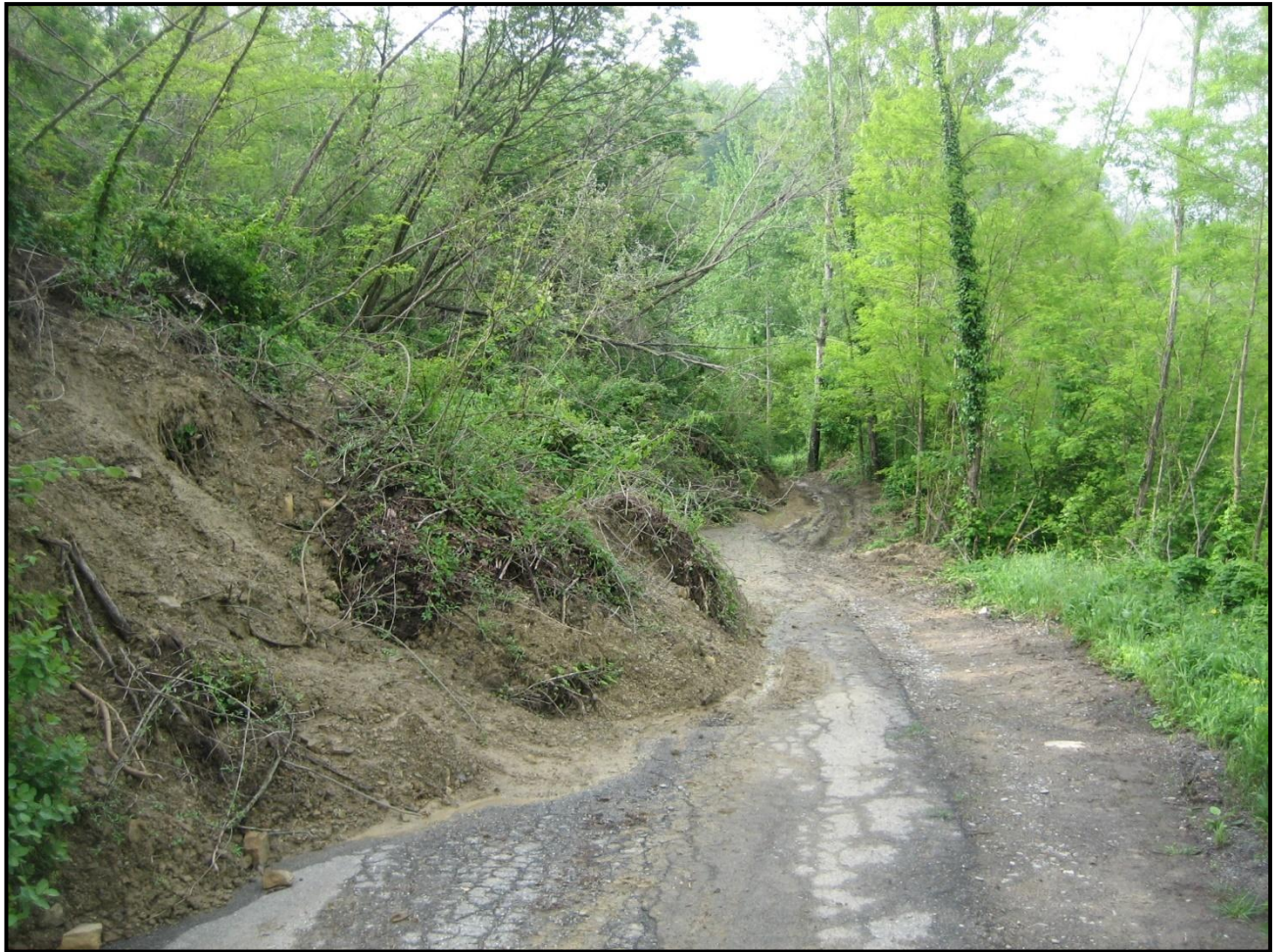
Fig. 1: Fotografia a valle dell'area interessata dal movimento franoso
