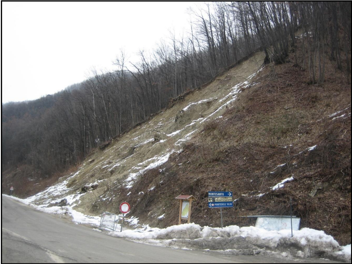
Fig. 3: Fotografia di un tratto di versante interessato dal movimento franoso
