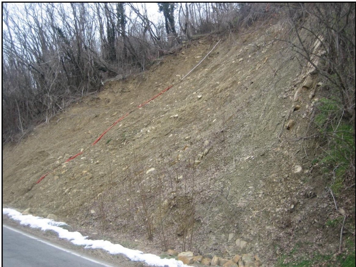
Fig. 4: Fotografia di un tratto di versante interessato dal movimento franoso
