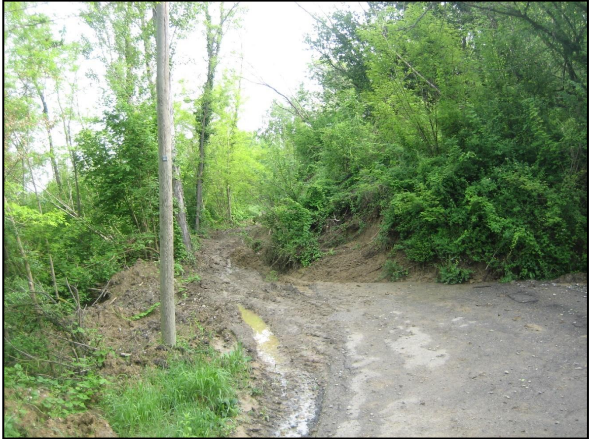
Fig. 2: Fotografia da valle dell'area interessata dal movimento franoso
