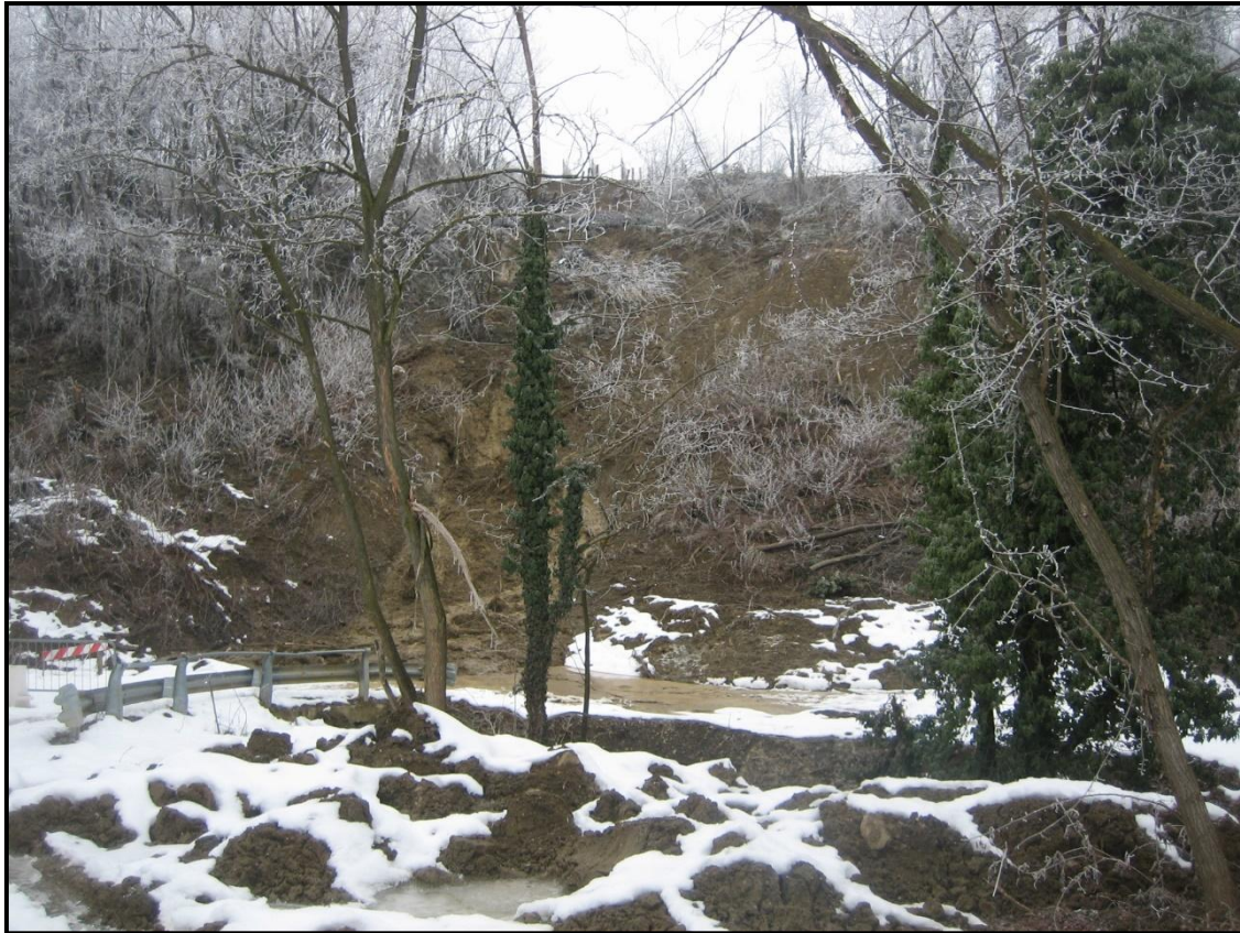
Fig. 2: Fotografia dell'area interessata dal movimento franoso
