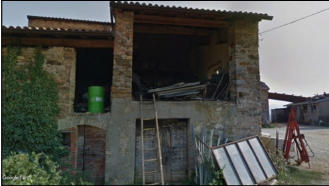
Documentazione fotografica - Edificio Y Fonte: Google Maps - Google Earth
