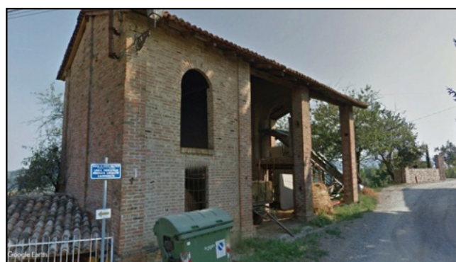
Documentazione fotografica - Edificio N Fonte: Google Maps - Google Earth
