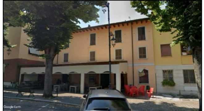
Documentazione fotografica - Edificio J Fonte: Google Maps - Google Earth
