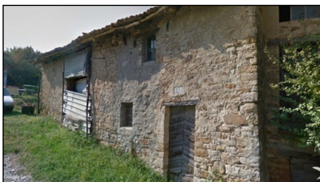
Documentazione fotografica - Edificio U Fonte: Google Maps - Google Earth
