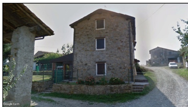
Documentazione fotografica - Edificio V Fonte: Google Maps - Google Earth
