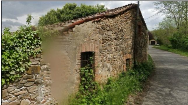
Documentazione fotografica - Edificio A Fonte: Google Maps - Google Earth
