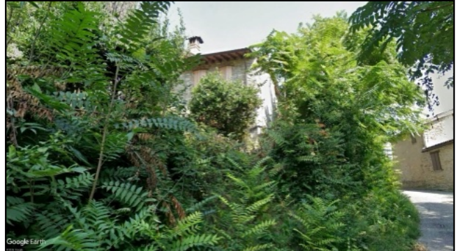
Documentazione fotografica - Edificio B Fonte: Google Maps - Google Earth
