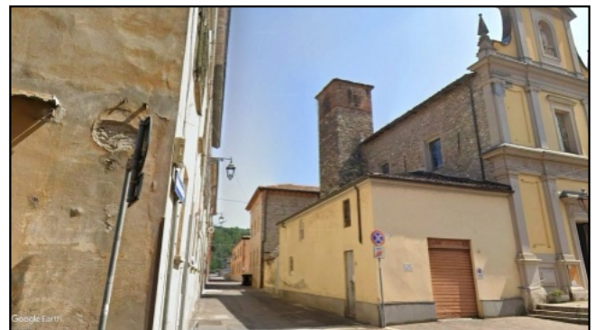
Documentazione fotografica - Edificio N Fonte: Google Maps - Google Earth
