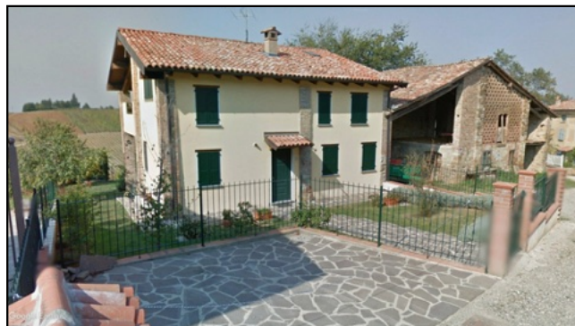
Documentazione fotografica - Edificio J Fonte: Google Maps - Google Earth
