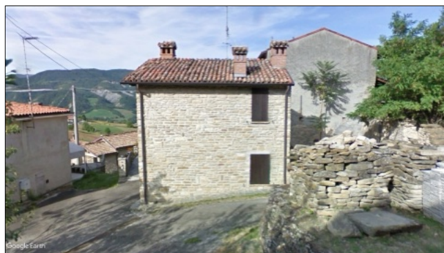
Documentazione fotografica - Edificio F Fonte: Google Maps - Google Earth
