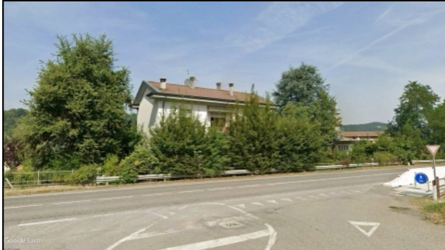
Documentazione fotografica - Edificio A Fonte: Google Maps - Google Earth
