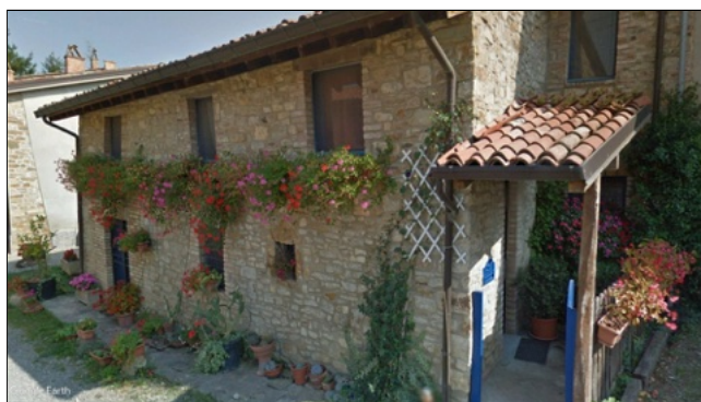
Documentazione fotografica - Edificio H Fonte: Google Maps - Google Earth
