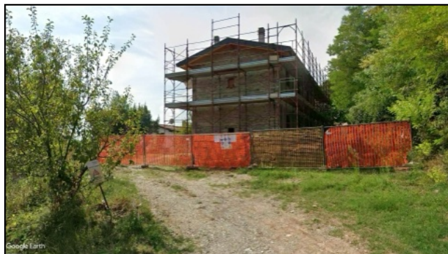
Documentazione fotografica - Edificio B Fonte: Google Maps - Google Earth
