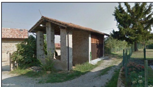
Documentazione fotografica - Edificio S Fonte: Google Maps - Google Earth
