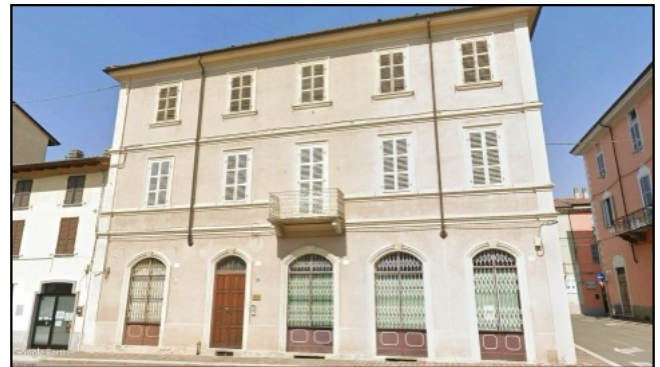
Documentazione fotografica - Edificio D Fonte: Google Maps - Google Earth
