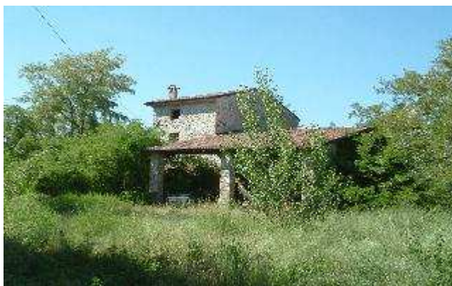
Fabbricato n° 40 Ar2
